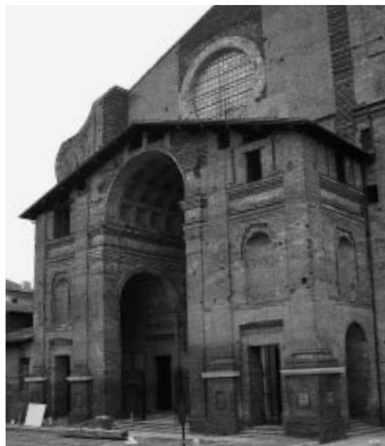
La volta centrale a lacunari e il sottarco d'ingresso, coperti da un sottile strato di intonaco di calce: il degrado si caratterizzava per la presenza di numerosi distacchi, lacune, erosioni dei giunti, depositi e guano. Sulle murature si evidenzia uno strato di scialbatura.
