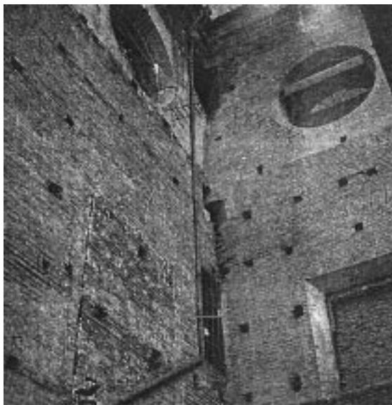
fiche. Esistono mattoni di attesa, ancora visibili sul lato nord-ovest del transetto nord, che erano destinati a facilitare l'ammorsatura del portico al transetto.
