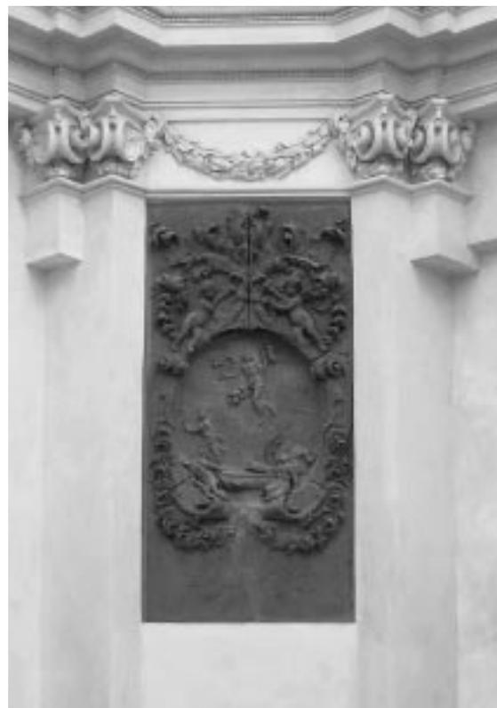
Tracce delle nicchie di alloggiamento dei rilievi in terracotta, riscoperte durante i lavori.
