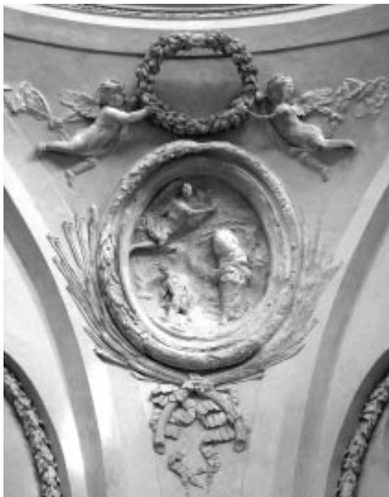
zone in cui erano stati rilevati difetti di adesione tra i vari strati o distacchi di elementi decorativi sono stati fissati prima di intervenire con le operazioni di pulitura; gli elementi ormai staccati sono stati rincollati mediante una malta fluida composta da calce idraulica Lafarge e resina acrilica del tipo Acril 33 al 20%. La stessa miscela, riducendo la percentuale di resina al 3%, è stata utilizzata tramite iniezione, per fissare le porzioni di stucco in fase di stacco.
