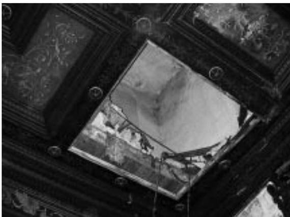
Il complesso si trova in uno stato di estremo abbandono: sono evidenti i crolli, anche nelle coperture, che hanno reso precarie le strutture sia verticali che orizzontali.
