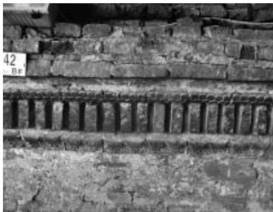
A DESTRA, pronao, interno del vano della volta centrale dopo la pulitura ed un blando consolidamento dei giunti di malta.
